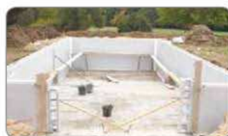
k Structure avec emplacement pour escalier
